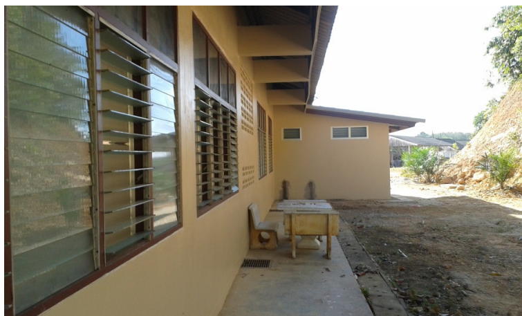
ภาพที่ 3 หอพักด้านนอกอาคารที่แล้วเสร็จ
