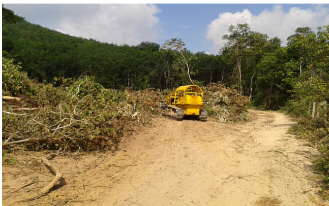
ภาพที่ 6 เครื่องจักรเข้าทำการเพื่อล้มต้นไม้และปรับพื้นที่เพื่อปลูกป่าสนน้ำมัน
