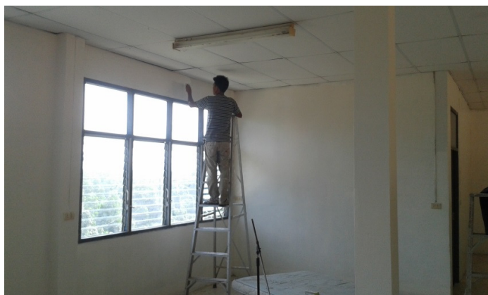
ภาพที่ 2 การซ่อมแซมหอพักนักศึกษาภายใน
