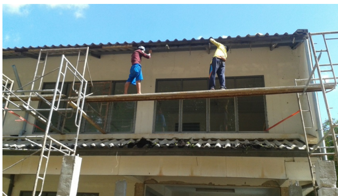
ภาพที่ 1 การซ่อมแซมหอพักนักศึกษาภายนอก
