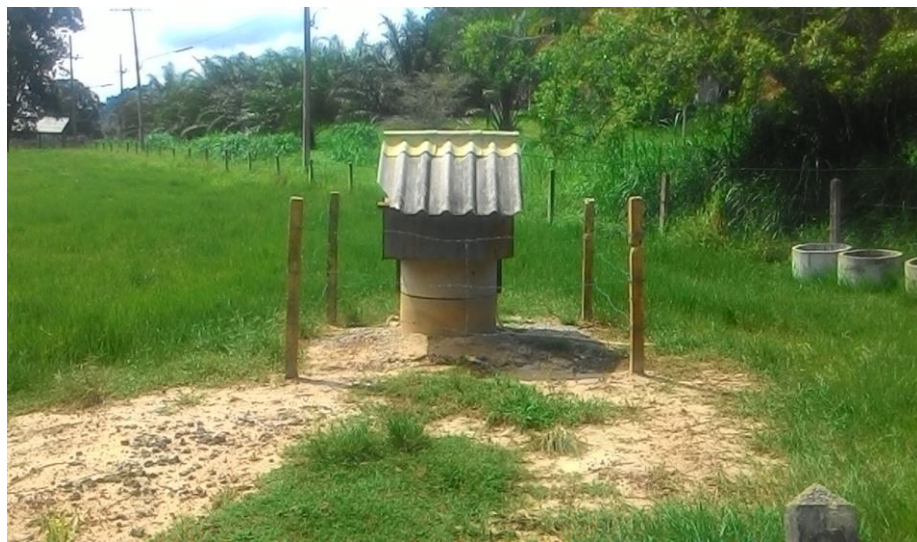
ภาพที่ 7. การดำเนินการขุดเจาะระบบน้ำตื้น บ่อน้ำตื้นที่แล้วเสร็จพร้อมใช้งาน (เดือนเมษายน 2559)
