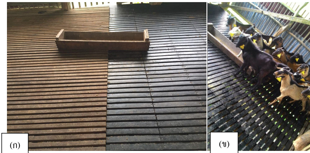
ภาพที่ 20 เปรียบเทียบพื้นไม้ระแนงจริงกับพื้นไม้ระแนงเทียม (ก) และสภาพแพะที่เลี้ยงในคอกที่ปูพื้น ด้วยไม้ระแนงเทียม (ข)
