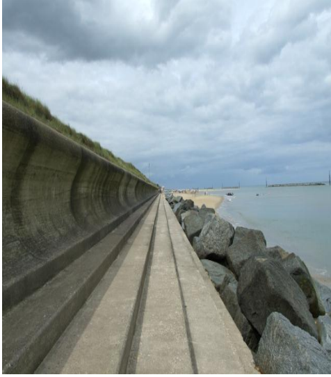
ภาพที่ 8 กำแพงกันคลื่น (ซ้าย) และ รอทหรือคั่นดักทราย (ขวา)
