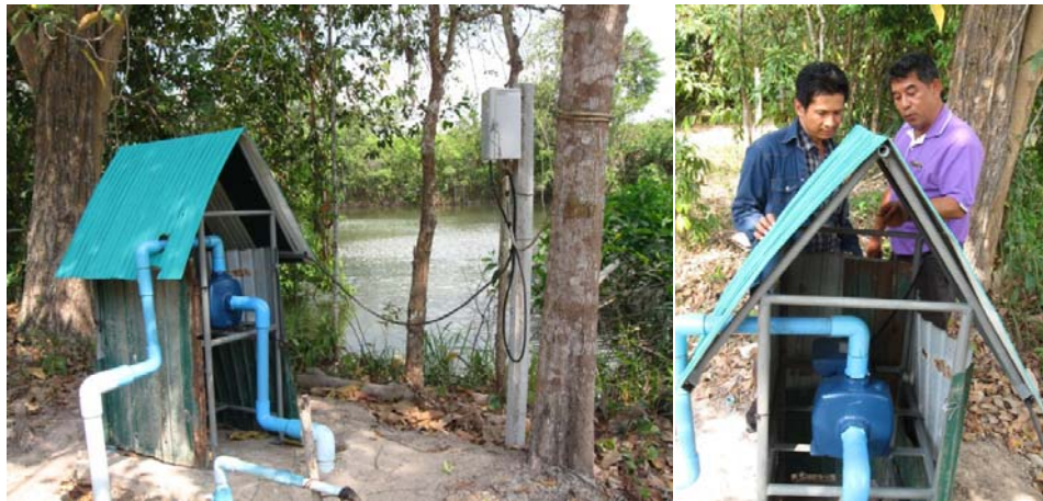
ภาพที่ 3 เครื่องสูบน้ำเครื่องใหม่ที่ติดตั้งเรียบร้อย และการทดลองเดินเครื่อง
