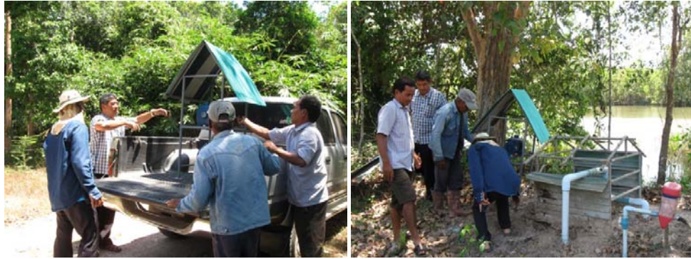
ภาพที่ 2 การขนย้ายและติดตั้งเครื่องสูบน้ำเครื่องใหม่
