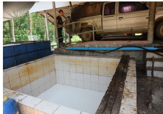
บ่อพักน้ำยางและท่อ PVC สำหรับลำเลียงน้ำยางขึ้นในถัง บนรถยนต์ เพื่อนำไปจำหน่าย
