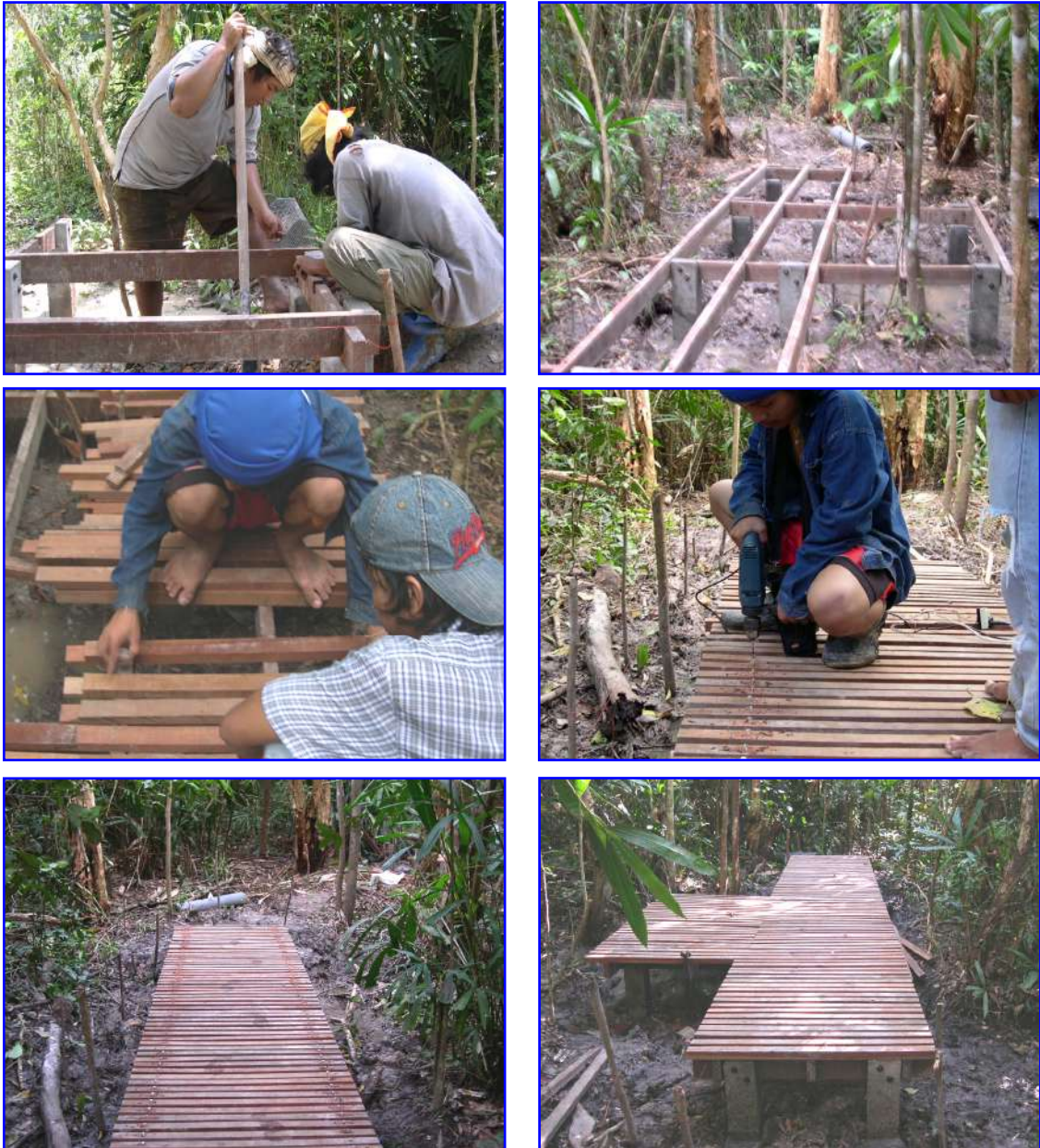
ภาพที่ 39 การสร้างสะพานไม้ยกระดับในแปลงโครงการรวบรวมและอนุรักษ์พันธุ์ผักพื้นบ้านและไม้ผลพื้นเมืองภาคใต้ แปลงป่าพรุ(4/1)
