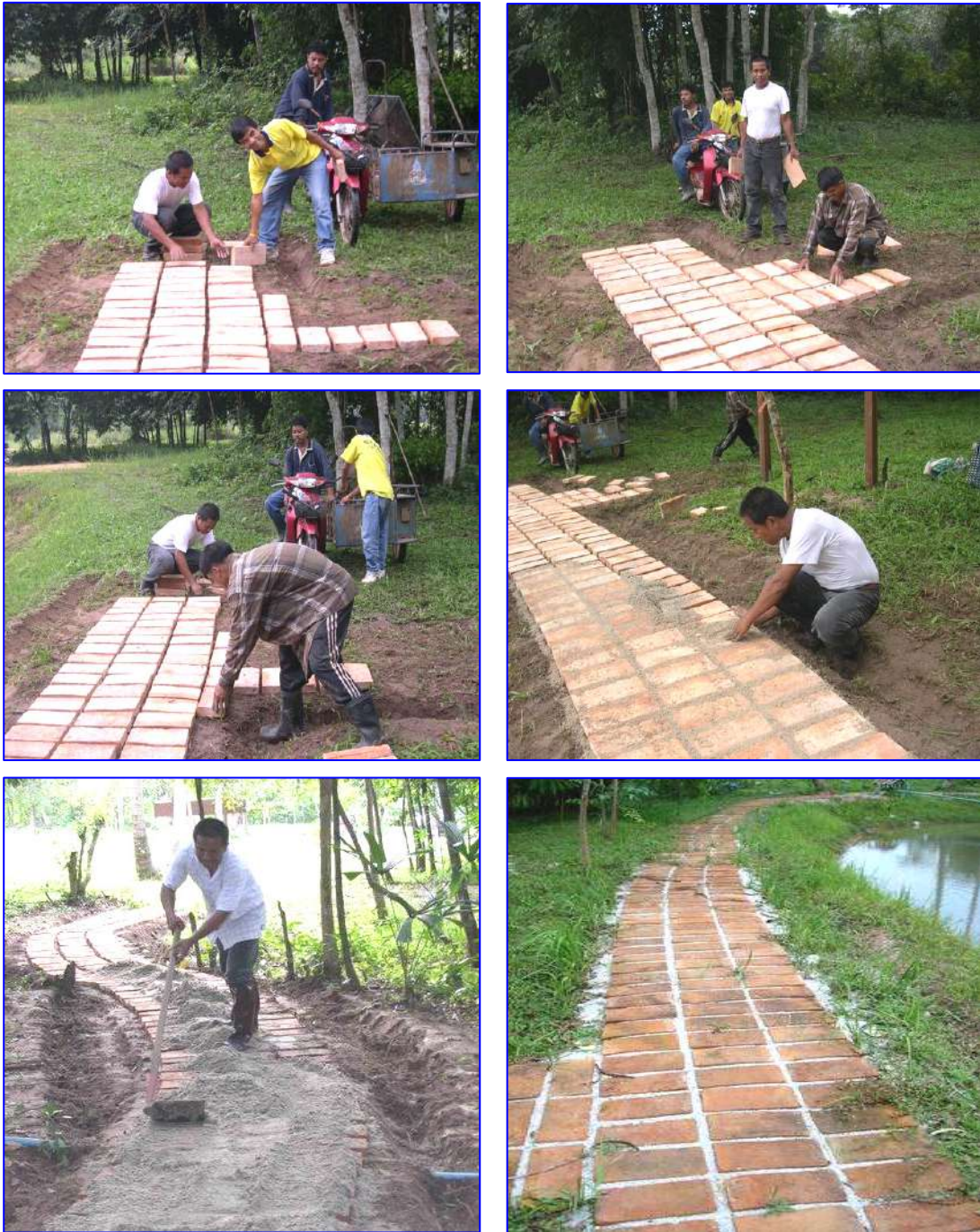
ภาพที่ 44 การจัดทำทางเดินไปยังบริเวณที่จะสร้างบ้านตัวอย่างเกษตรกรในแปลง โครงการรวบรวมและอนุรักษ์พันธุ์ผักพื้นบ้านและไม้ผลพื้นเมืองภาคใต้ แปลงย่อย 5/1
