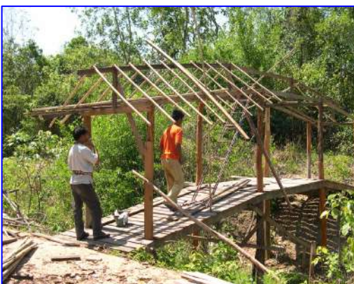
ภาพที่ 15 การสร้างสะพานไม้ข้ามคูระบายน้ำ เข้าพื้นที่โครงการรวบรวมและอนุรักษ์พันธุ์ผักพื้นบ้านและไม้ผลพื้นเมืองภาคใต้ ระหว่างวันที่ 1-22 เม.ย. 2547
