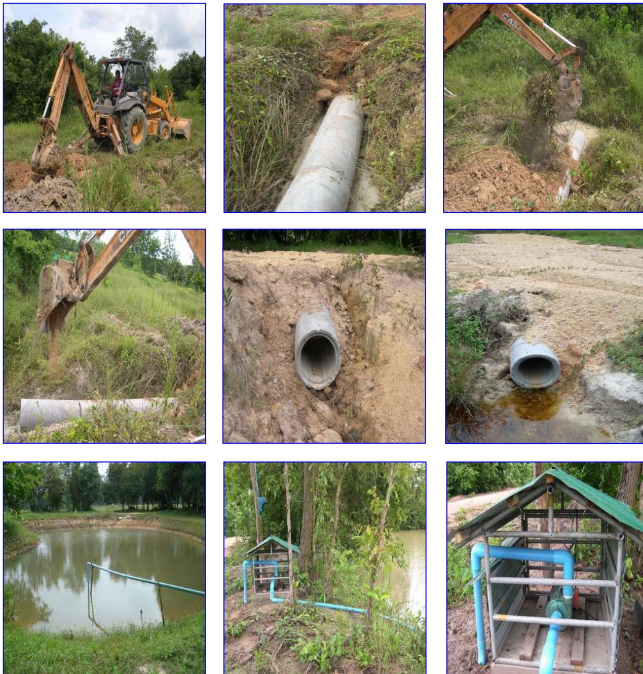
ภาพที่ 17 การวางท่อส่งน้ำเข้าและน้ำออกจากสระเก็บน้ำของโครงการรวบรวมและอนุรักษ์พันธุ์ผักพื้นบ้านและไม้ผลพื้นเมืองภาคใต้
