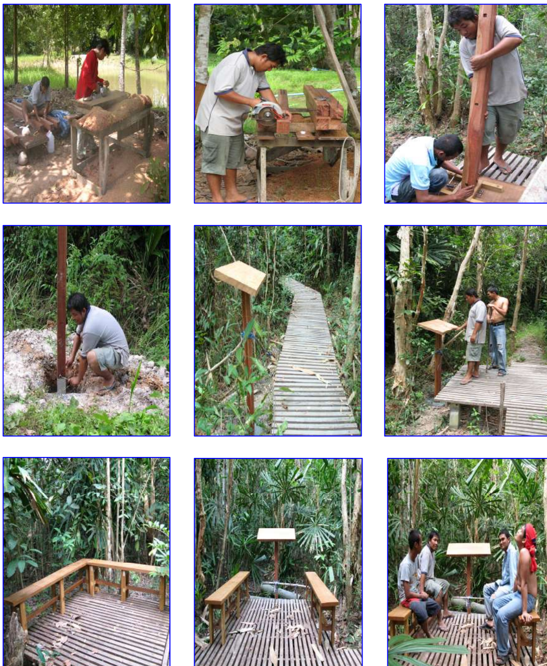
ภาพที่ 40 การจัดสร้างป้ายองค์ความรู้ และที่นั่งริมสะพานไม้บริเวณทางเดินศึกษาธรรมชาติป่าพรุ ในแปลงโครงการรวบรวมและอนุรักษ์พันธุ์ผักพื้นบ้านและไม้ผลพื้นเมืองภาคใต้ แปลงย่อย 4/1
